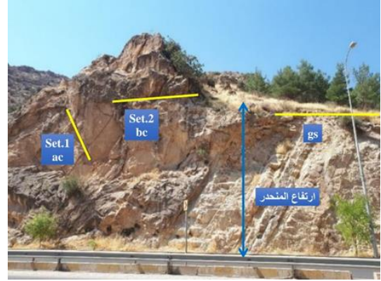
اللوحة (11) منظر امامي للمنحدر في المحطة رقم (4) يوضح الانقطاعات في الكتلة الصخرية أتجاه التصوير (NW).
