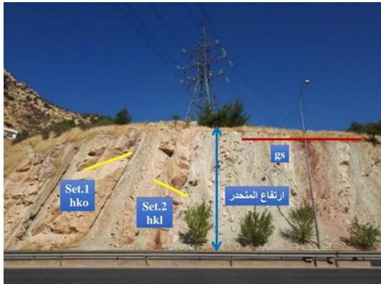
اللوحة (12) منظر امامي للمنحدر في المحطة رقم (5) توضح الانقطاعات في الكتل الصخرية، اتجاه التصوير (NW).
